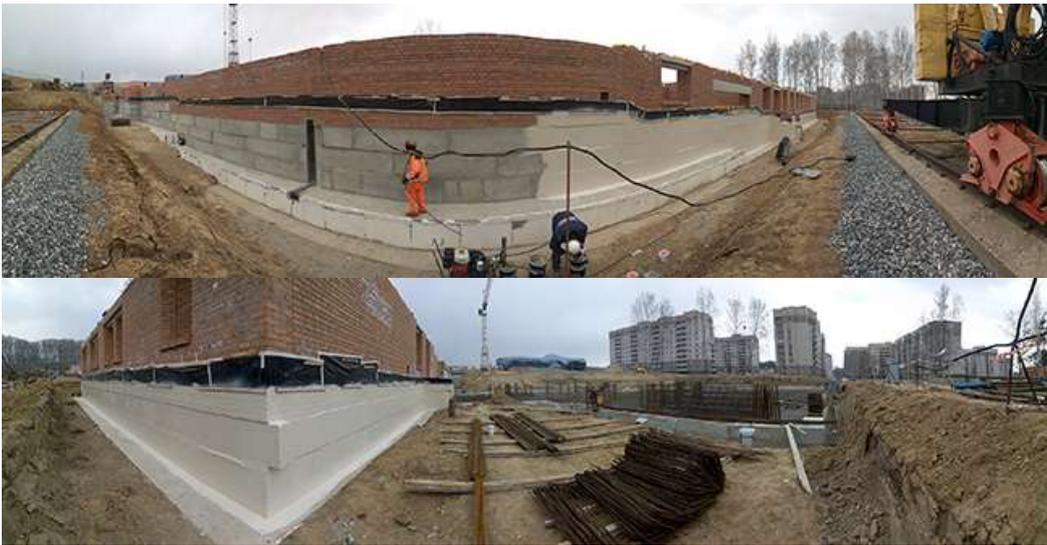
Работы с использованием **полиуретановой мастики СЛАВЯНКА® «Зимняя»** можно проводить при температуре наружного воздуха от  $-20^{\circ}\text{C}$  до  $+10^{\circ}\text{C}$ . Для проведения работ при температуре наружного воздуха выше  $+10^{\circ}\text{C}$  рекомендуется использовать **полиуретановую мастику СЛАВЯНКА®**.
