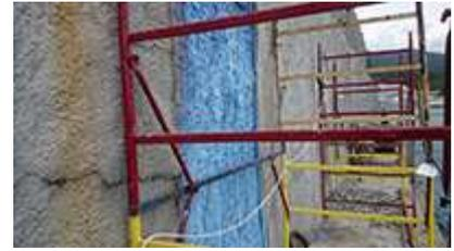
*Подготовка поверхности причальной стенки морского порта с помощью латексной грунтовки ЛАХТА® перед нанесением ремонтного состава ЛАХТА® быстрый ремонт.*
